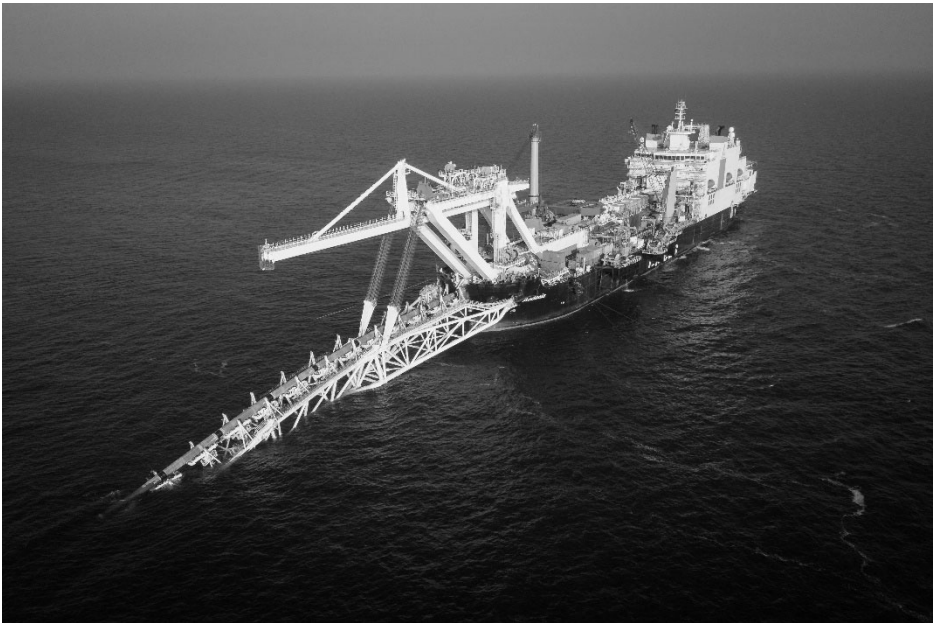
Nord Stream 2: Verschweißt und versenkt. Bei den Verlegungsarbeiten
