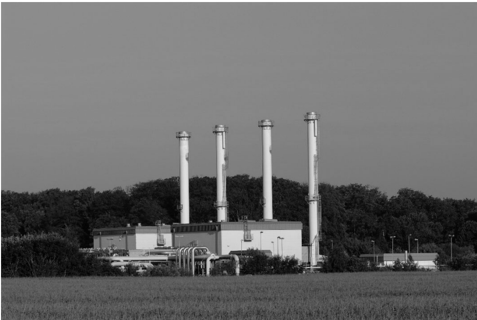
Speicherplatz: Oberirdische Bauten über dem Unterirdischen Gasspeicher in Rehden
