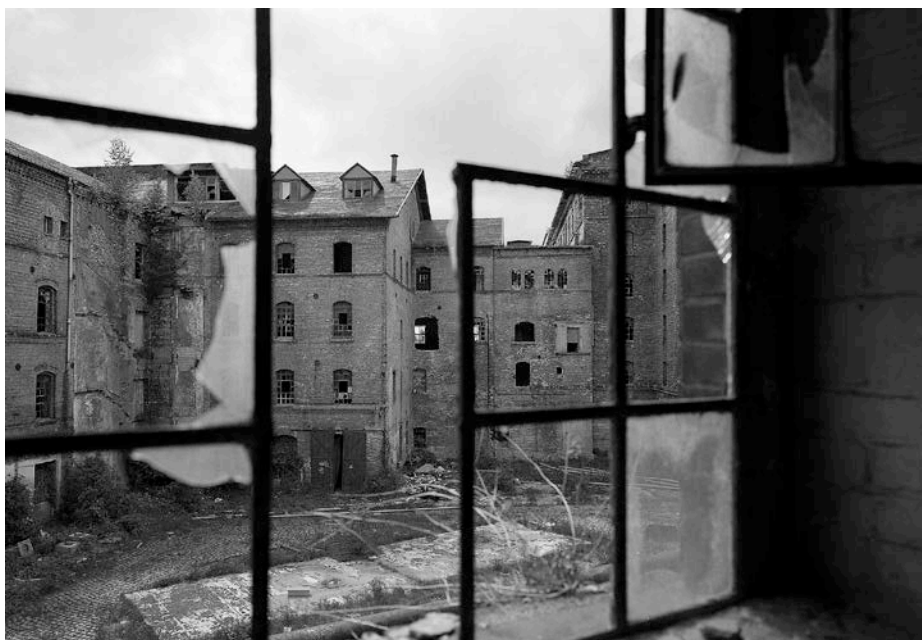
Stillgelegt. Industrieruinen im Osten. Halle (Saale) © www.christophlingg.com
